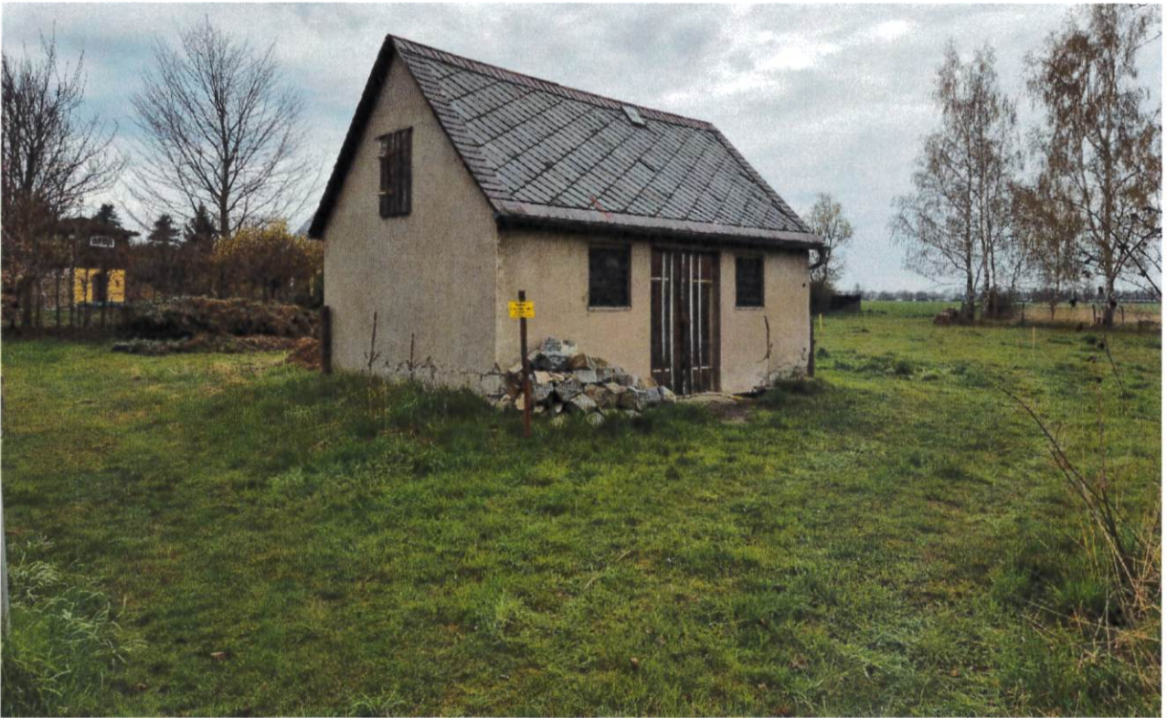
Abbildung 2 Blick auf das Baugrundstück aus Richtung Süd-Ost (Foto 13.04.2026, Gemeindeverwaltung)
