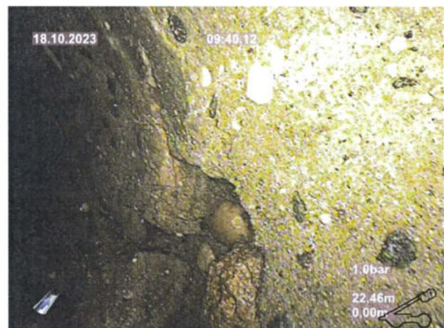
In den Bereichen wo bereits repariert wurde ist die Sanierung mittels Inliner nicht notwendig und es kommt zu Kosteneinsparungen.
