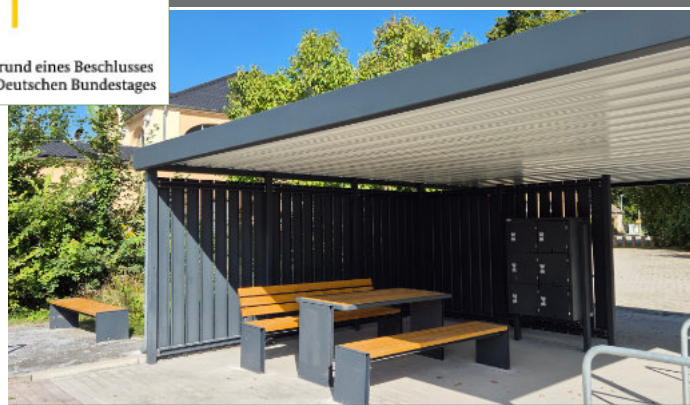
Rastplatz mit Akkuladestellen
