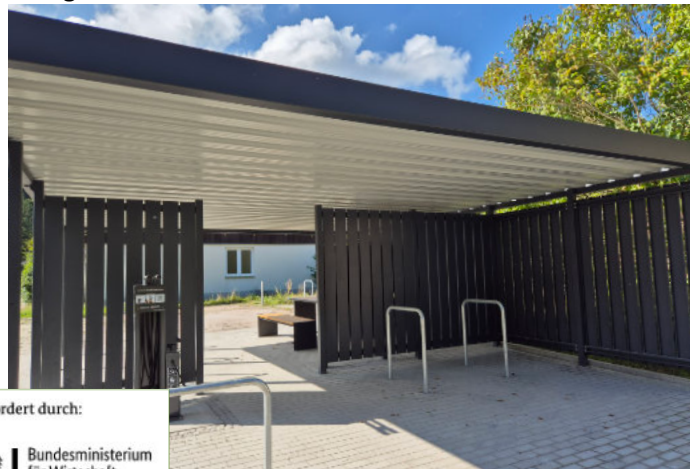
Überdachter Fahrradrastplatz mit Reparaturstation
